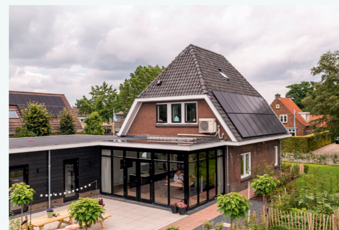
Panasonic levert totaal oplossing voor verwarmen en koelen luxe gerenoveerde woning in Voorthuizen. Aquarea-Airconditioning
