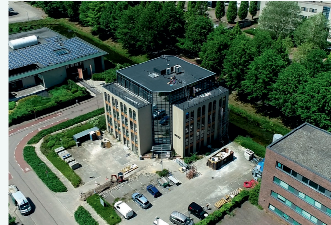
3 warmtepompen appartementen in Amersfoort. Aquarea
