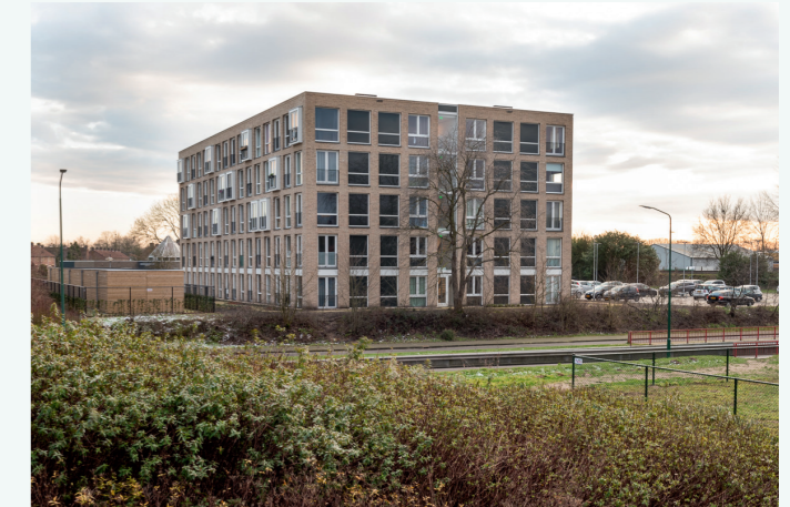
75 Warmtepompen appartementen Cuijk. Aquarea All in One
